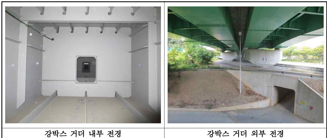
【사진 3.2.3】 강박스 거더 전경(대구)
