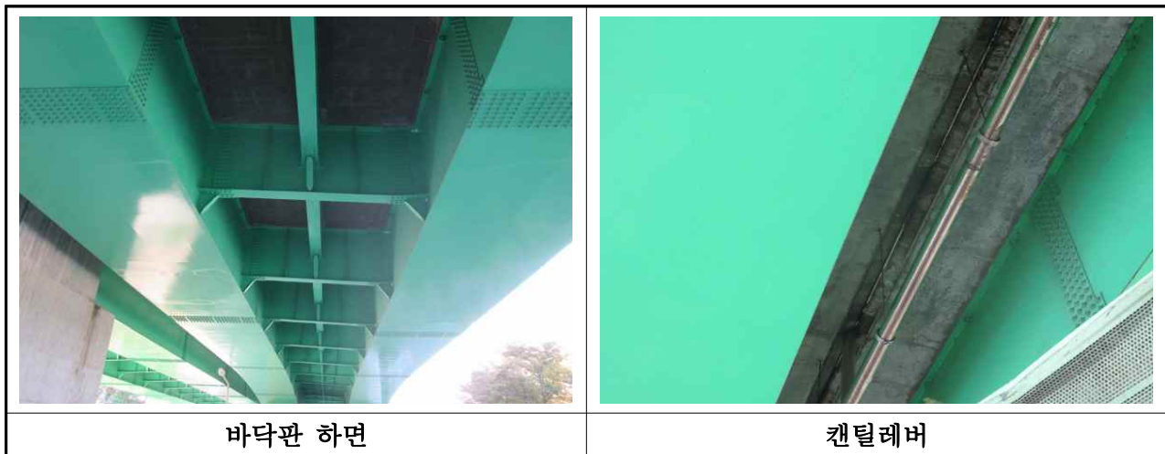
【사진 3.3.1】 바닥판 전경(부산)
