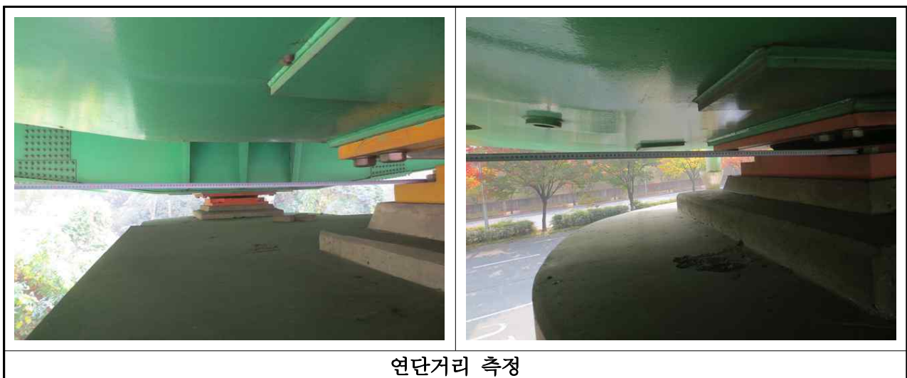
【사진 3.3.14】 연단거리 측정 전경(부산)
