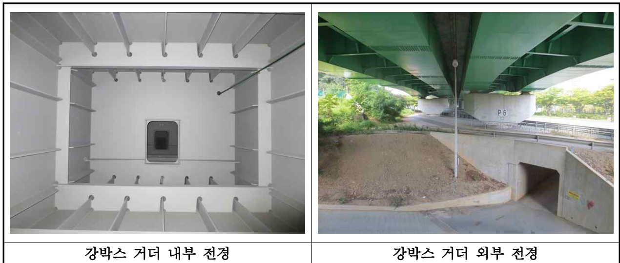
【사진 3.3.3】 강박스 거더 전경(부산)
