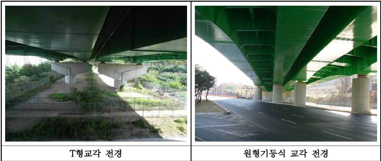
【사진 3.2.10】 교각 전경(대구)
