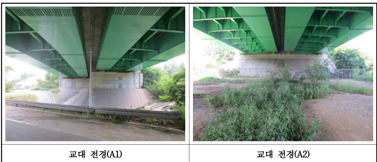
【사진 3.3.8】 교대 전경(부산)
