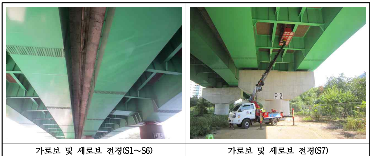
【사진 3.3.6】 가로보 및 세로보 전경(부산)
