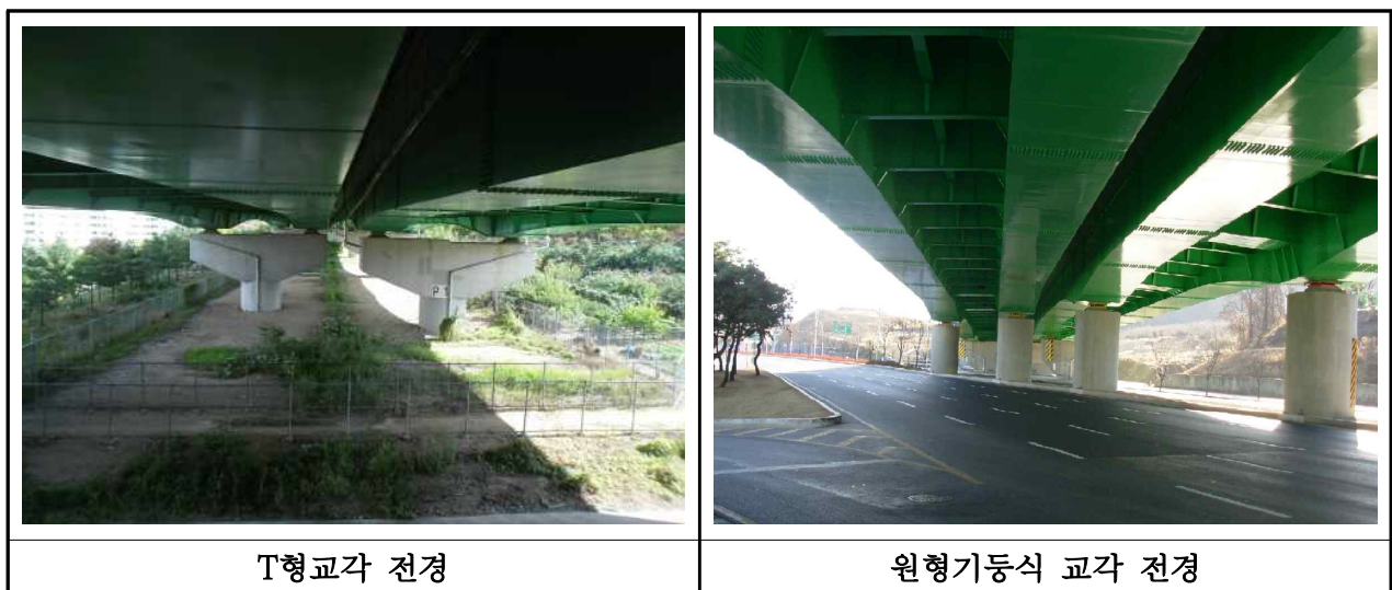
【사진 3.3.10】 교각 전경(부산)
