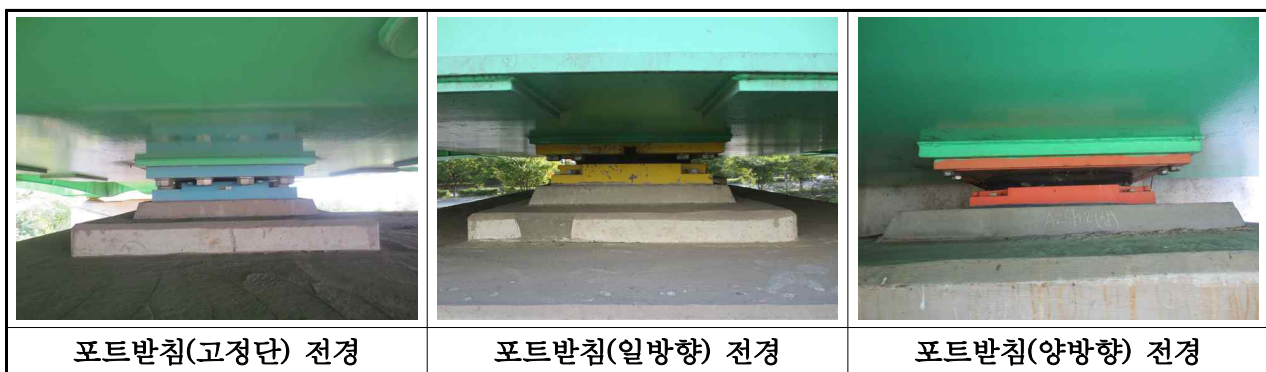
【사진 3.2.12】 교량받침 전경(대구)
