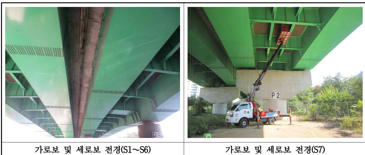
【사진 3.2.6】 가로보 및 세로보 전경(대구)
