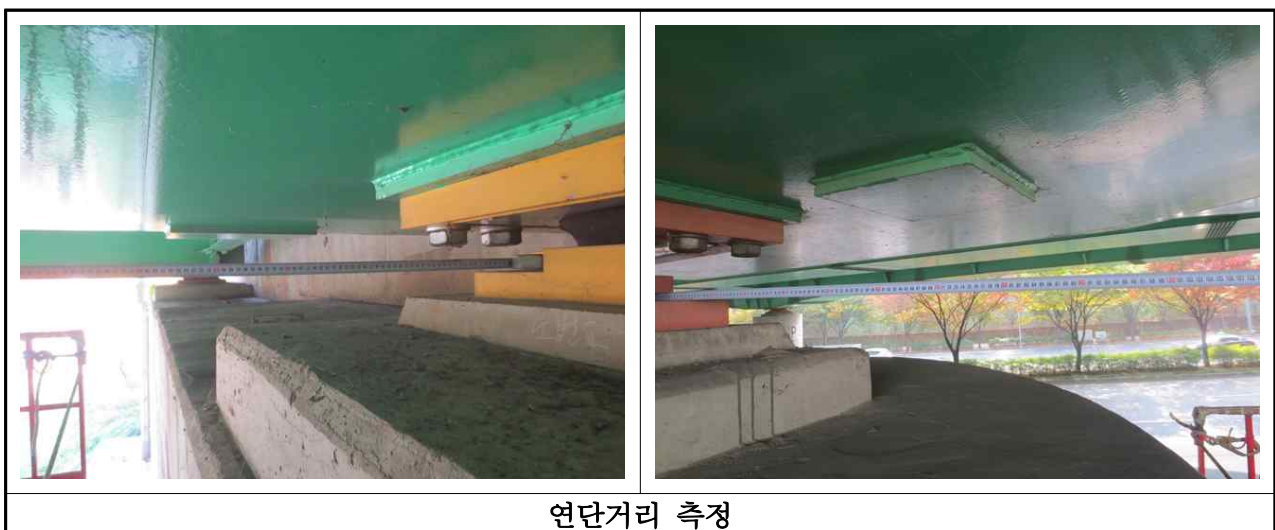
【사진 3.2.14】 연단거리 측정 전경(대구)
