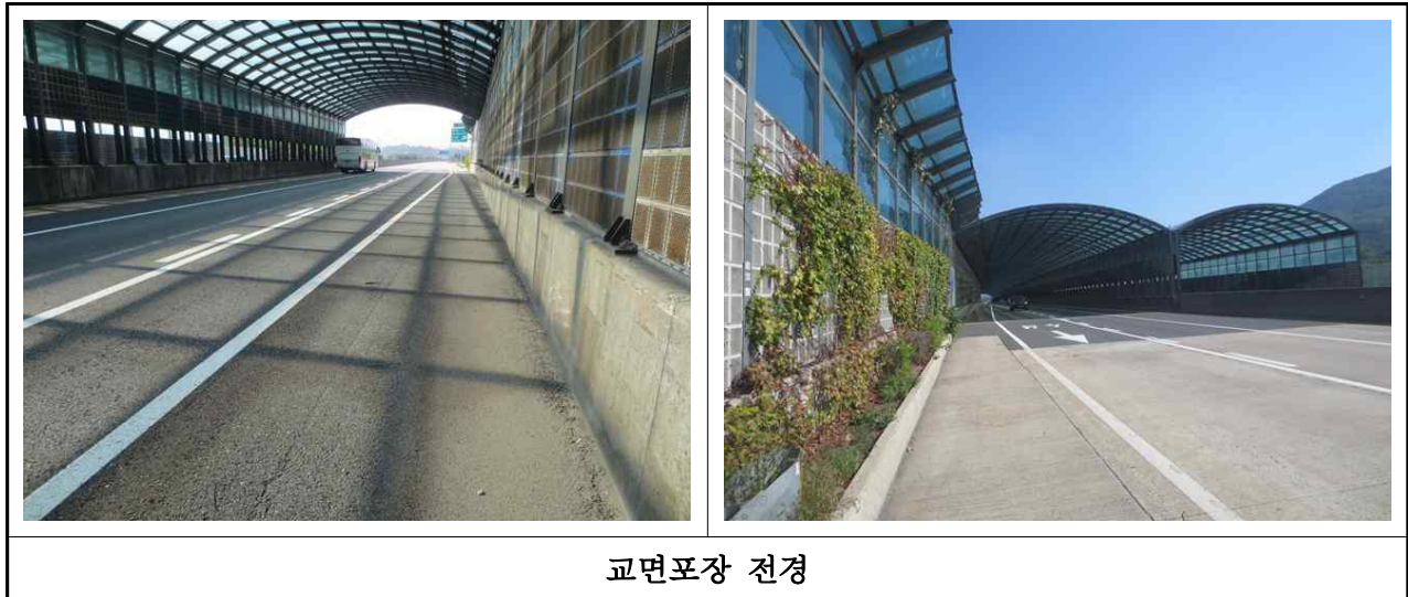
【사진 3.2.18】 교면포장 전경(대구)
