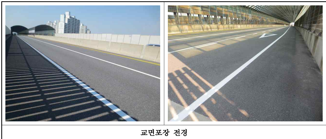
【사진 3.3.18】 교면포장 전경(부산)
